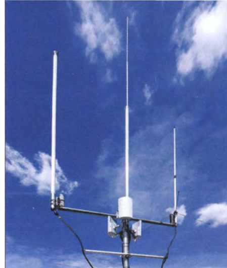
Antennensystem von DB0BS; links die 70-cm-Koaxialkabel-Antenne, Mitte die Blitzfangstange und rechts eine Duoband-Antenne für 2 m und 70 cm; die drei Ubiquiti-ähnlichen weißen Gehäuse dienen einem kommerziellen Netzwerk-Provider in Bochum für dessen Verbindungen.
