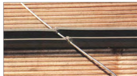
Bild 14: Montage der 2-mm-Elemente in einem Kabelkanal Fotos: DK7ZB
